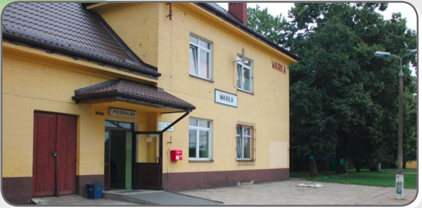
Dworzec kolejowy w Warce
