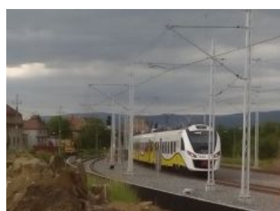
Ruszyła przebudowa trzech mostów
