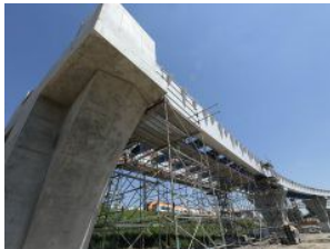
Kolejne prace przy łącznicy kolejowej w Krakowie
