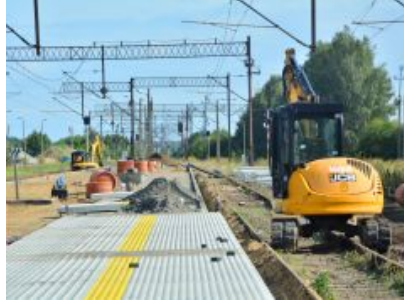
Remont linii Działdowo - Olsztyn wkracza w końcową fazę
