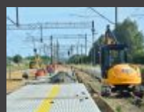
Remont linii Działdowo - Olsztyn wkracza w końcową fazę
